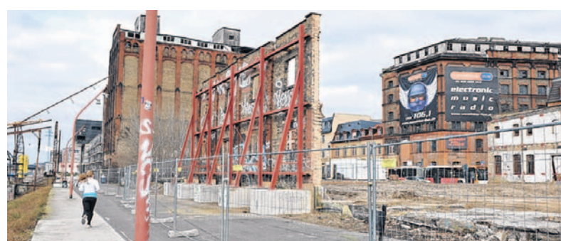
Der Bauplatz für das neue Kreativwirtschaftszentrum im Jungbusch, in das die Stadtgalerie 2015 einziehen soll.
